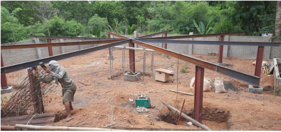
Die Bauarbeiten schreiten voran....
